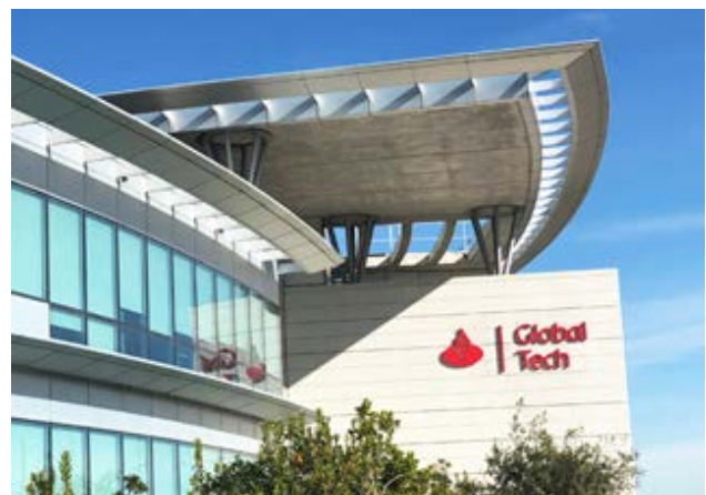
Edificio Athambra, Boadilla del Monte, España
